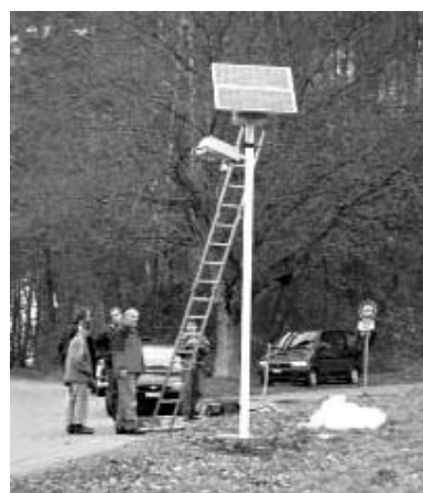
Photo: pose de lampadaires solaires à Wohlen.
