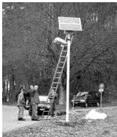
Photo: pose de lampadaires solaires à Wohlen.
